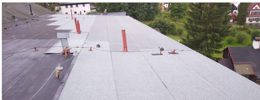
Oprava střechy na základní škole
