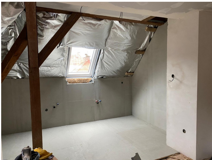
Snímky z pokračující rekonstrukce sauny MŠ a bytu ve zdr. středisku
